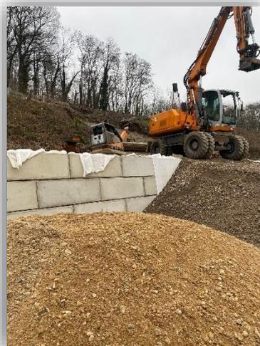
Abb. 6: Herstellung der unteren Schwergewichtsstützwand bei D-Gerresheim
