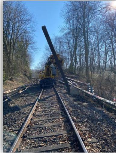
Abb. 1 und 2: Herstellung der Bohrlöcher und Einbringung der Doppel-T-Stahlträger
