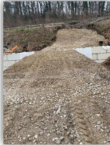
Abb. 5: Herstellung einer Baustraße zur Hinterfüllung und zum Bau der oberen Schwergewichtsstützwand bei D-Gerresheim (im oberen Bereich ist der Hangrutsch noch sichtbar)
