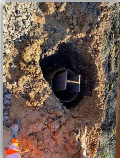
Abb. 3 und 4: Einbringung der Doppel-T-Stahlträger
